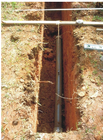
Figura 2.4 – Tubo de pvc implantado na linha de tubulação hidráulica
