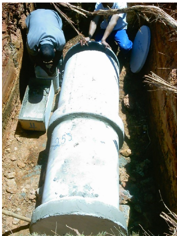
Figura 2.6 – Instalação da manilha de concreto “N” no SCGR do IAG/USP
