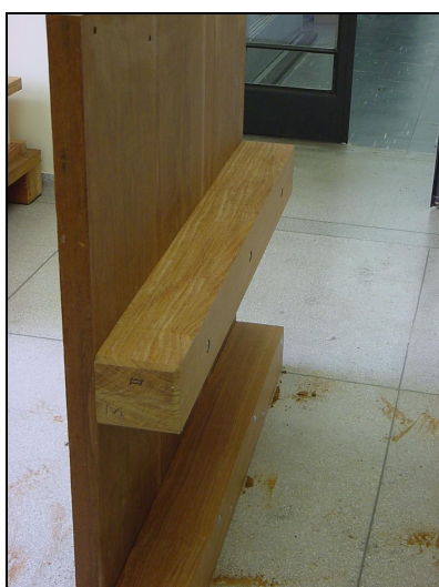
Figura 3.2.2 Distribuição das vigas de madeira na base do molde.
