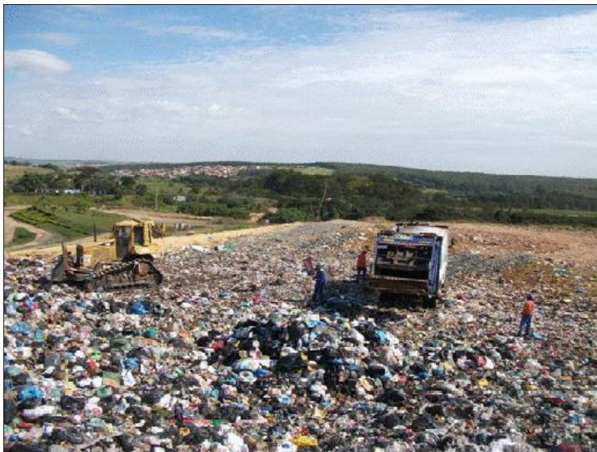
Figura 3.5 Compactação do RSU no interior da célula experimental
