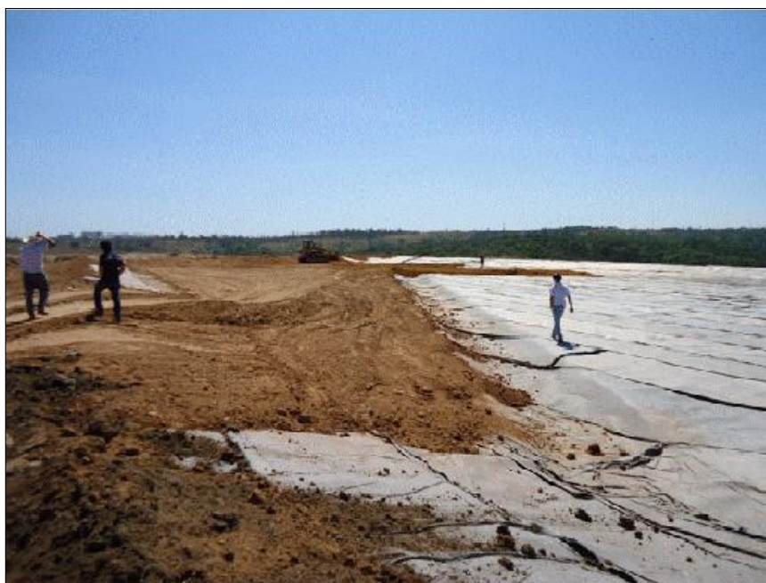
Figura 3.3 Instalação da camada de geomembrana no início da instalação da célula experimental.
