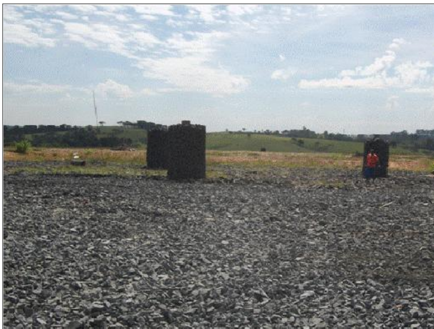
Figura 3.4 Sistema de drenagem finalizada.
