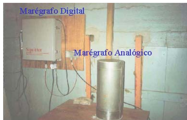
Figura 3.18 – Marégrafos analógico e digital do Datum de Imbituba.
