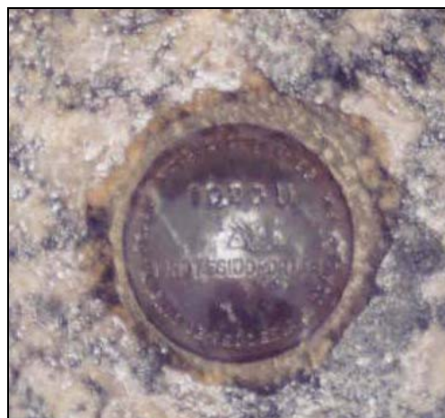
Figura 4.3 – Chapa metálica cravada em concreto
