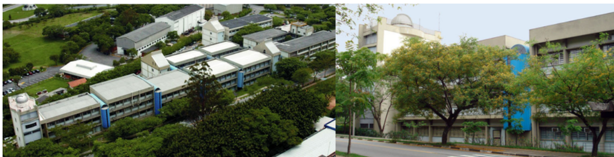
Figura 8 – Instituto de Astronomia, Geofísica e Ciências Atmosféricas localizado na cidade universitária da Universidade de São Paulo (IAG/ USP) visão aérea e frontal
