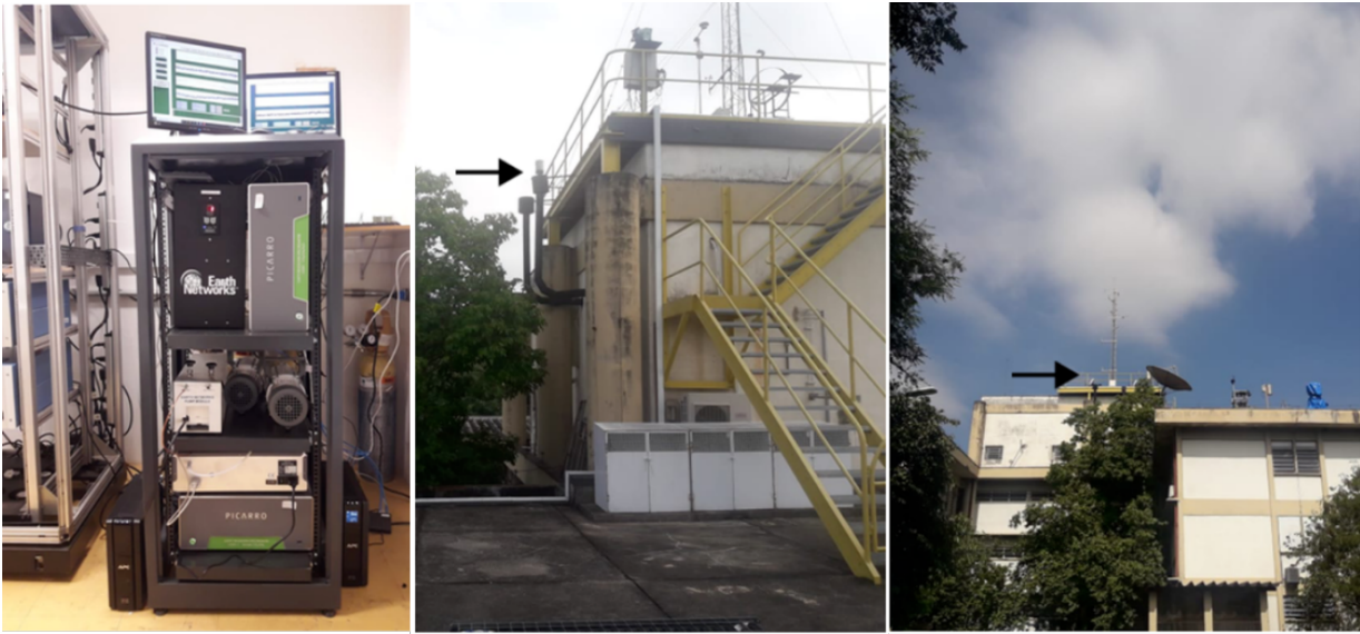
Figura A.2: Imagens da estação de medição do IAG-USP
