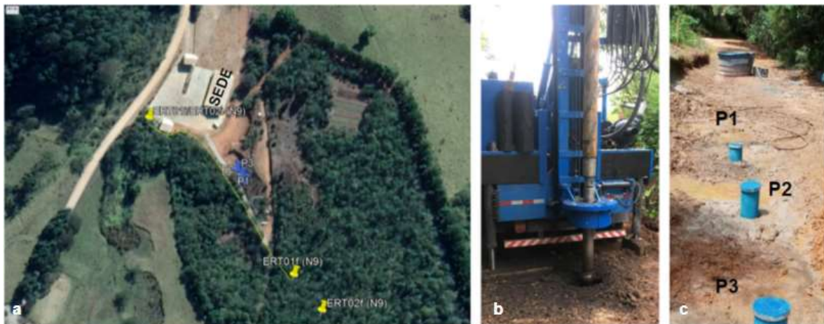
Figura 6.4 - Posicionamento dos poços P1, P2 e P3 próximos à sede do Projeto Conservador de Águas, assim como as linhas ERT01 e ERT02 que foram utilizadas para escolher o local da perfuração (A). Sistema de perfuração rotopneumático (B) e situação final dos poços à direita (C).
