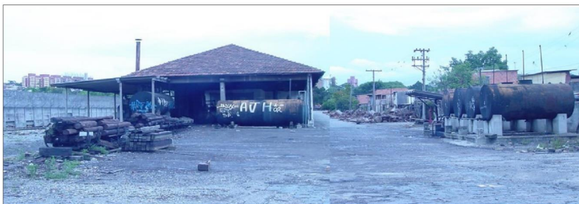
Figura 2. Setor de tratamento químico de dormentes de madeira na parte sul do terreno (foto da década de 90). Fonte: Relatório do IPT do ano de 2010.
