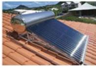
Os coletores solares utilizam do aquecimento da água com transformação de energia luminosa em energia térmica.
