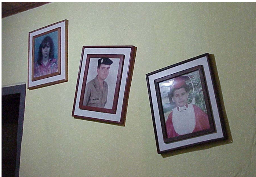
Fig. A1.5. Quadros deslocados na parede da sala na sede do Sítio Santo Antônio, perto da estação BEB1, pelo tremor de 02/04/2005. (Foto de Antônio Carlos Rocha, Tribuna Regional).
